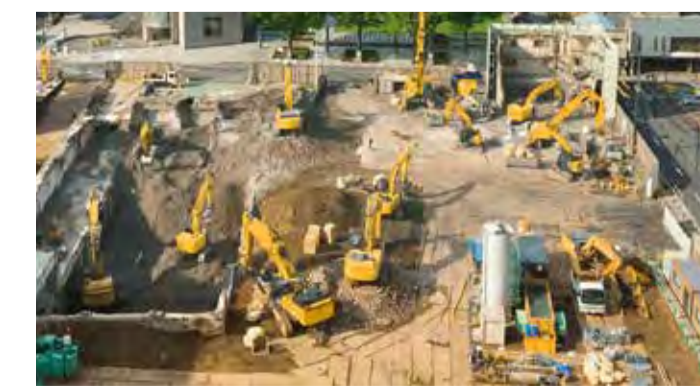
◆建築工事現場 最新工法を伝えるだけでなく、近隣住民への理解促進にも役立ちます。
